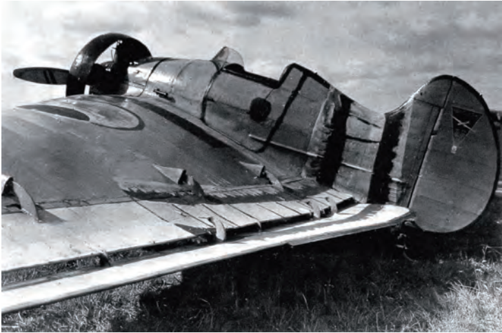
Aan de achterrand van de vleugel bevestigde panelen dienen als trim.
